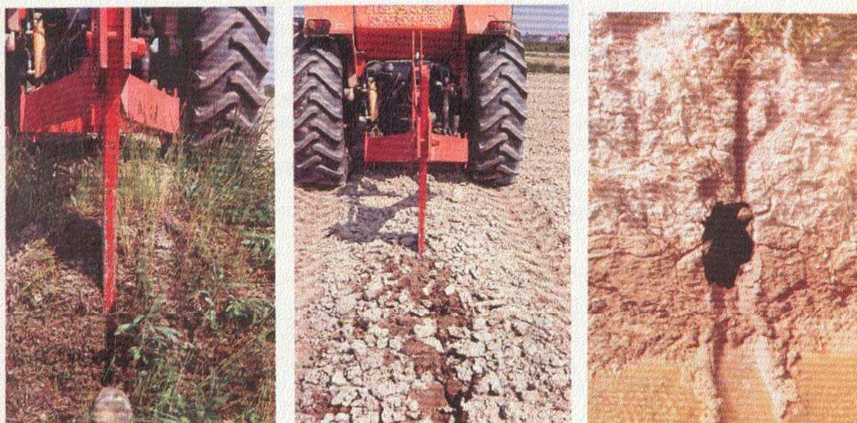
*Fig. 13.10.* — Drenaggio con aratro talpa: a sinistra l'aratro talpa che sta iniziando la formazione della galleria partendo da una scolina; al centro la fessurazione prodotta dallo strumento e a destra lo sbocco di una galleria già funzionante.
