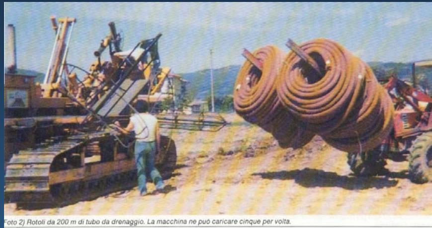
Foto 2) Rotoli da 200 m di tubo da drenaggio. La macchina ne può caricare cinque per volta.
