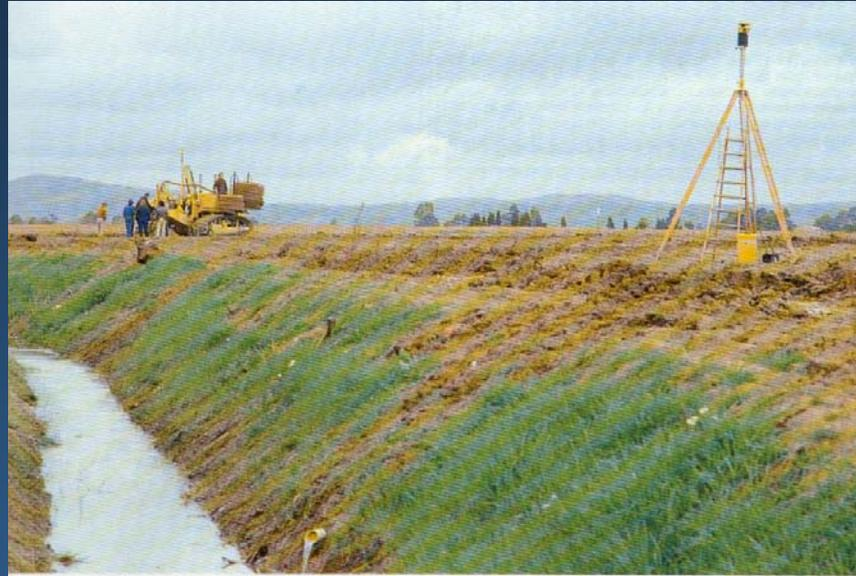
Foto 1) Trasmettitore laser che controlla la profondità di partenza e di posa di una posadreni a talpa.
