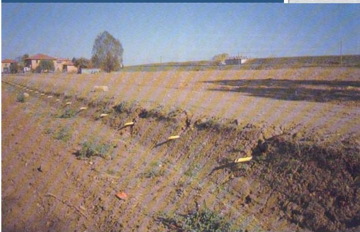
Foto 12) I numerosi terminali di sbocco dei dreni complicano notevolmente le operazioni di pulizia e risezionamento dei fossi collettori.
