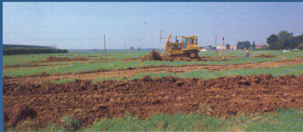
Foto 6) Livellamento superficiale tramite un grosso cingolato.
